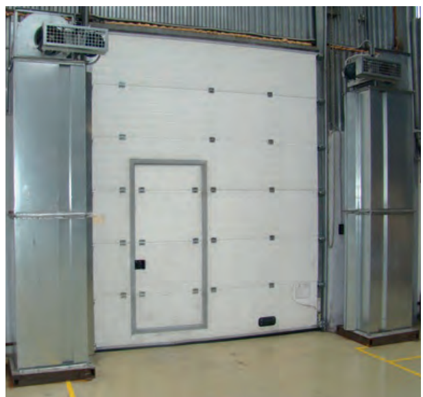
Перекрытие ворот двумя завесами AeroBlast
