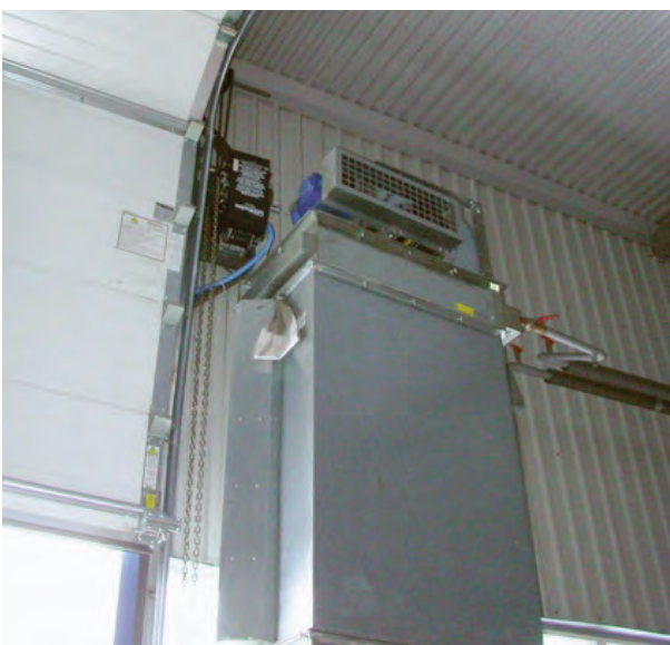
Перекрытие ворот одной завесой AeroBlast
