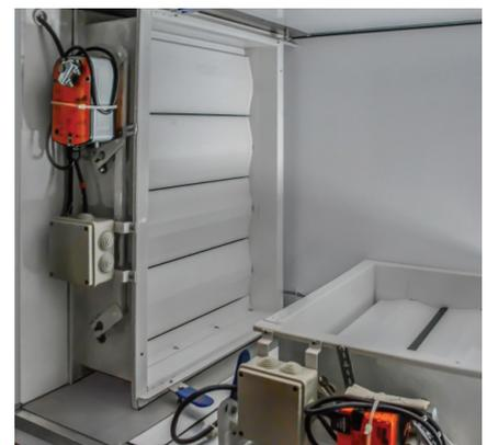
клапанов используются электроприводы с пружинным возвратом (220 В или 24 В) «открыто/закрыто» и плавного регулирования. Воздушные клапаны установок АКВАРИС всегда размещаются внутри корпуса установки. Это позволяет избежать образования конденсата на корпусе клапана.
