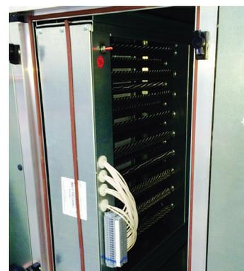
Для безопасной и безаварийной эксплуатации электронагревателей скорость воздуха в его сечении не должна быть менее 1,5 м/с. На это обстоятельство следует особо обращать внимание при выборе установки, а также при регулировании её расхода.
