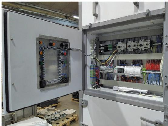
порядке также включены контрольно-измерительные приборы и исполнительные механизмы. Все датчики, за исключением тех, что должны устанавливаться вне установки АКВАРИС, монтируются внутри вентиляционной установки уже на заводе. При этом кроме размещения осуществляется электрическое подключение датчиков и электрических исполнительных механизмов (электродвигатели вентиляторов, электрические приводы воздушных заслонок, компрессоры и пр.) к шкафу управления.
